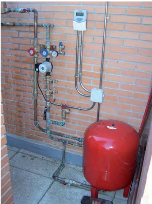
Detalle de la instalación del circuito primario.
