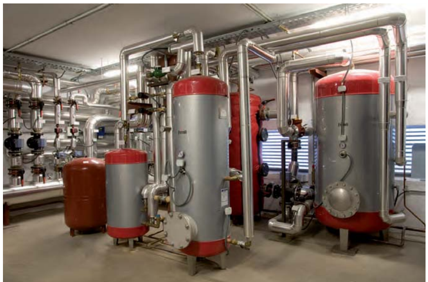
Depósitos de la instalación Energía Solar Térmica del Edificio Ferroli.
